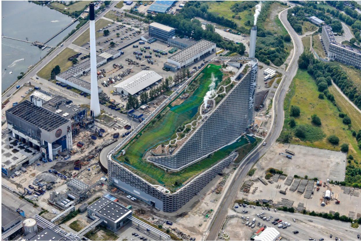
Incinérateur d'Amager Bakke à Copenhague • © Rasmus Hjortshoj
