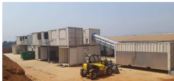
Un centre de tri modulaire "Val'Box" composé de conteneurs maritimes. Déployé au Cameroun
